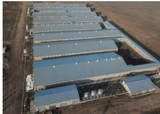
Santa Elena (genética porcina) Planta de Biogás en Gral Villegas
